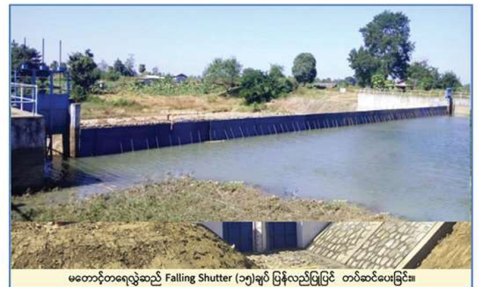
မတောင်တရေလွှဲဆည် Falling Shutter (၁၅)ချပ် ပြန်လည်ပြုပြင် တပ်ဆင်ပေးခြင်း။
