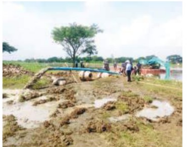
ငမိုးရိပ်ရေထိန်းတံခါးတွင်ပျိုးစုပ်လုပ်ပေးဆောင်ရွက်စဉ်။
